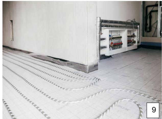
Um aufgrund der zahlreichen Rohrleitung in den Anschlussräumen eine optimale Dämmung zu gewährleisten, wurden in diesem Bereich die Klettrohre der Heizkreis in den Fluren – analog zu den Raum-Zuleitungen – in die x-net connect base Systemplatte eingelassen und abschließend mit dem x-net connect cover bedeckt. Somit ist auch hier eine maximale Wärmedämmung gegeben.
