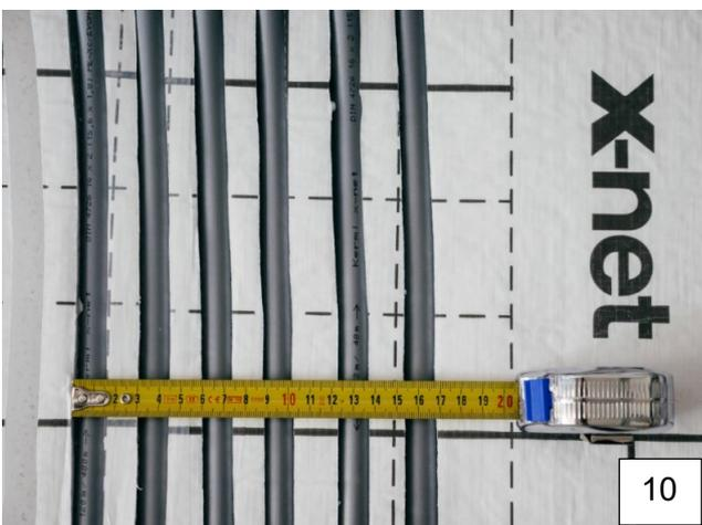
Der erhöhte Trittschallschutz des x-net connect plus Systems ist auch bei enger Anordnung der durchlaufenden Zuleitungen vollumfänglich gegeben.
